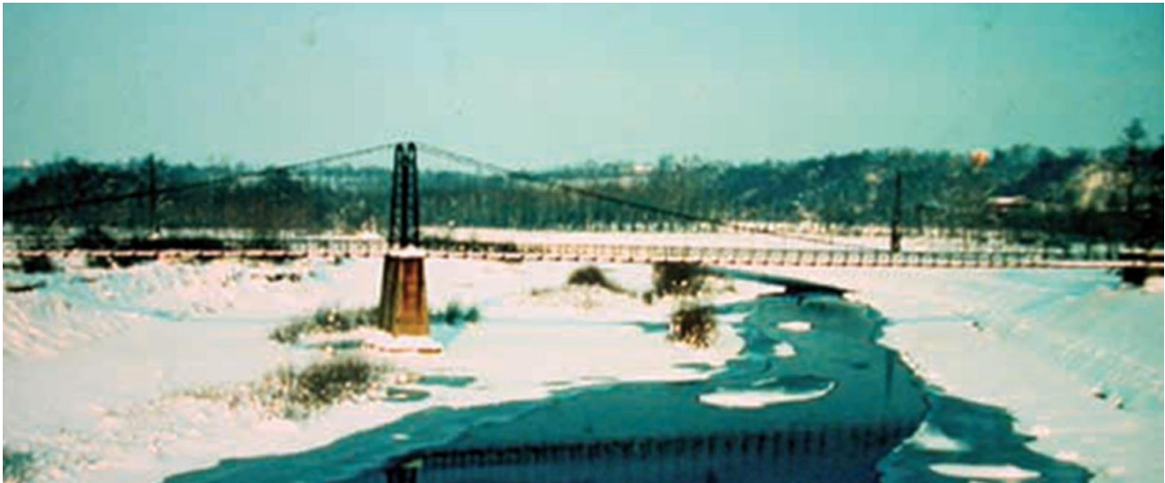
La passerella in ferro sull'Orba. Particolare della foto di G. Carrara, tratta dalla Guida di Capriata d'Orba , a cura di Mario Tambussa
